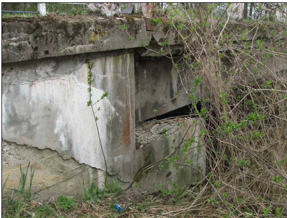
Zdj.22 Przyczółek prawobrzeżny (DW) - widoczne spękania oraz białe osady. Obsunięcie gruntu stożka nasypu i odsłonięte skrzydełko (stanowi zagrożenie dla stateczności podpory).
