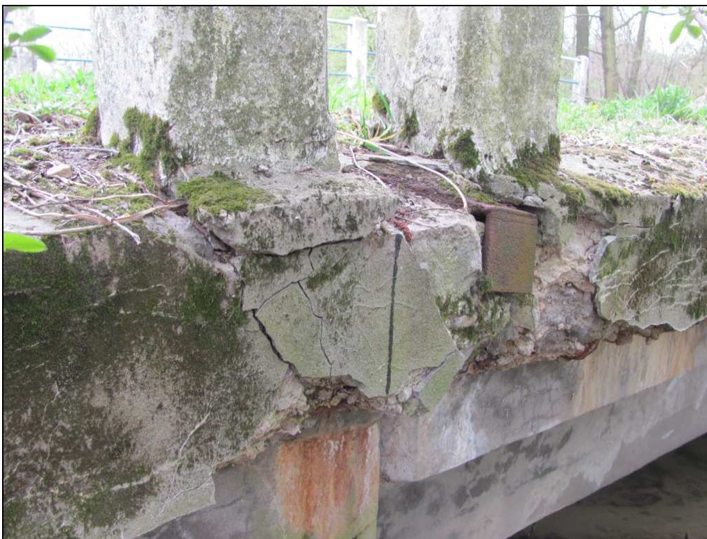
Zdj.13 Gzyms od strony górnej wody (w strefie dylatacyjnej) - widoczne spękania, korozja i ubytki betonu, korozja odsłoniętego zbrojenia, deformacja i korozja blachy osłonowej szczeliny dylatacyjnej.
