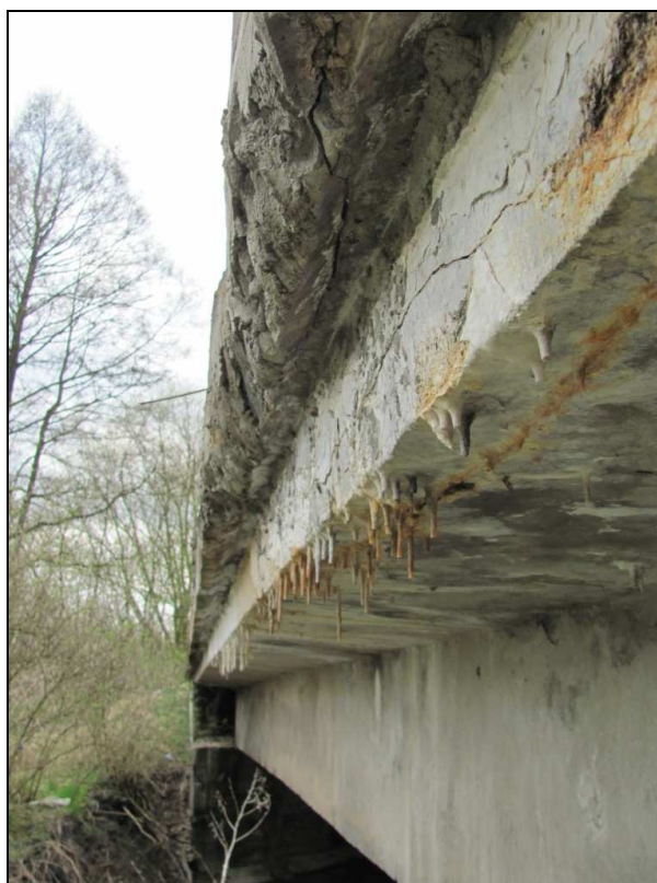
Zdj.14 Gzyms od strony dolnej wody - widoczna rozległa korozja, ubytki i spękania betonu. Przecieki i osady na wsporniku konstrukcji nośnej.
