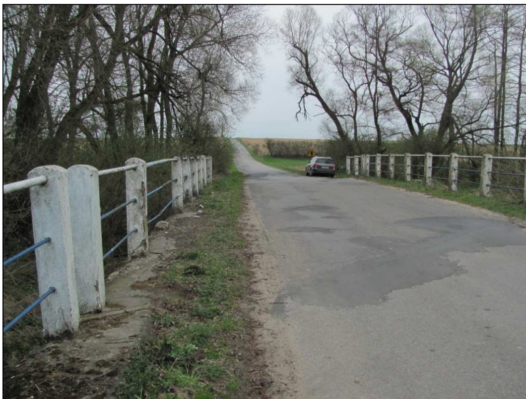
Zdj.5 Nawierzchnia jezdni - widoczne deformacje oraz zanieczyszczenia i wegetacja roślin w strefach przykrawężnikowych.
