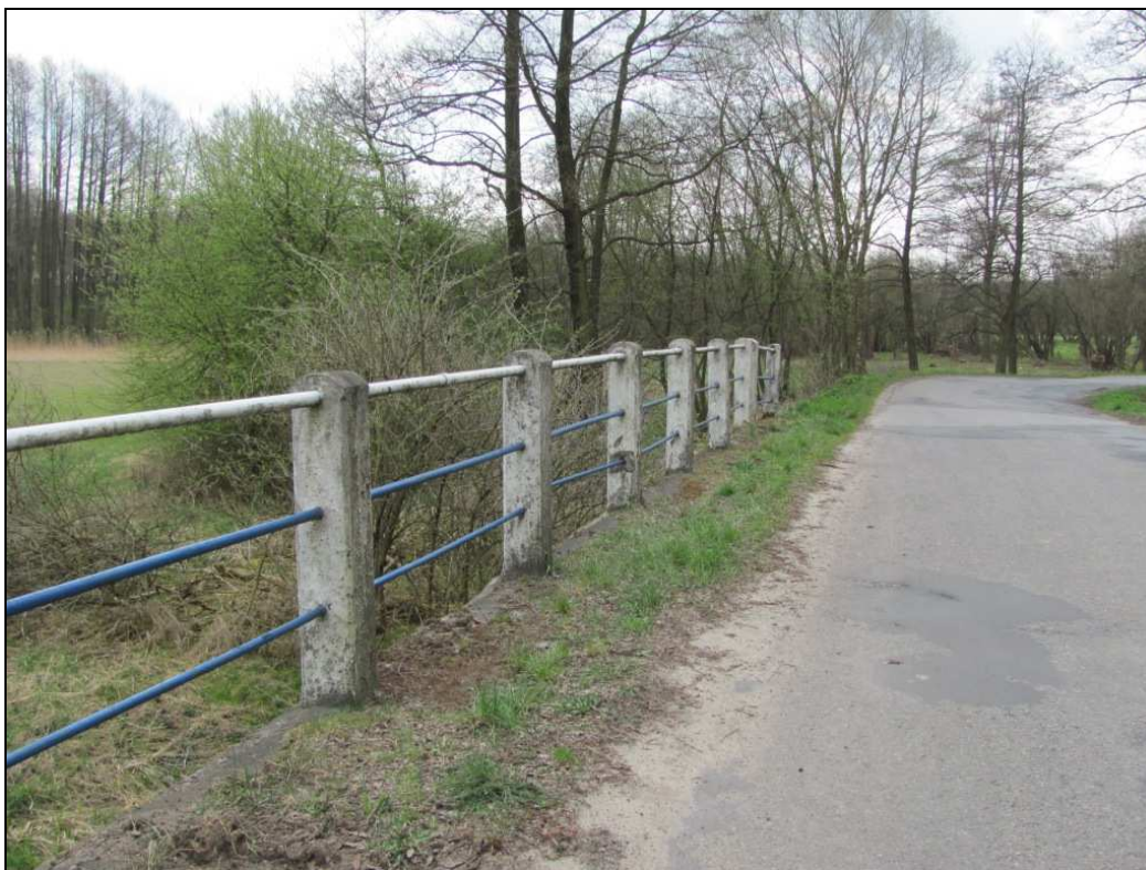
Zdj.7 Nawierzchnia jezdni wraz z opaską od strony dolnej wody - widoczne zanieczyszczenia betonowej opaski, ubytki betonu słupków balustrady, korozja powierzchniowa stalowych przeciągów.
