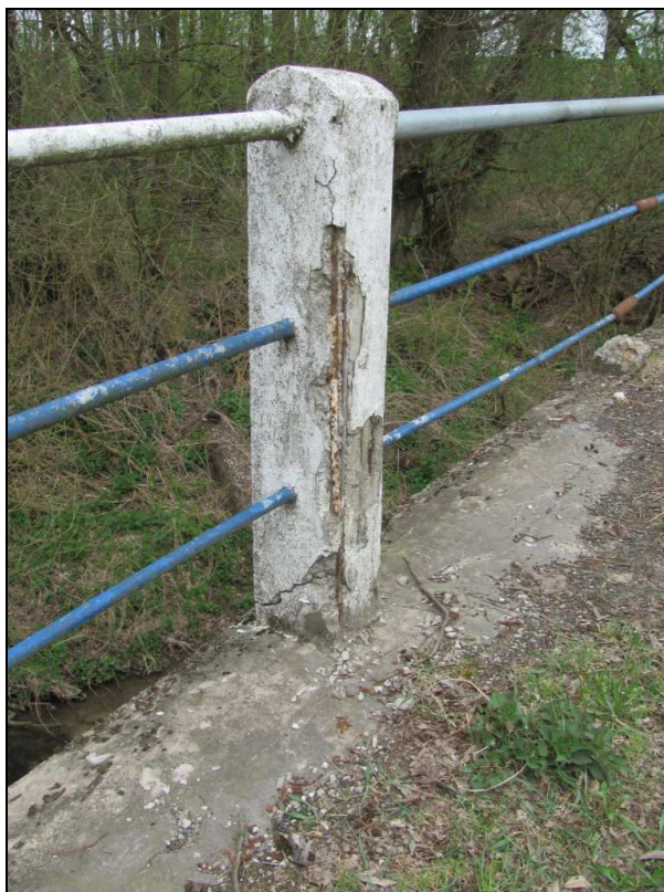
Zdj.11 Słupek i przeciagi balustrady - widoczna korozja i ubytki betonu oraz korozja zbrojenia.
