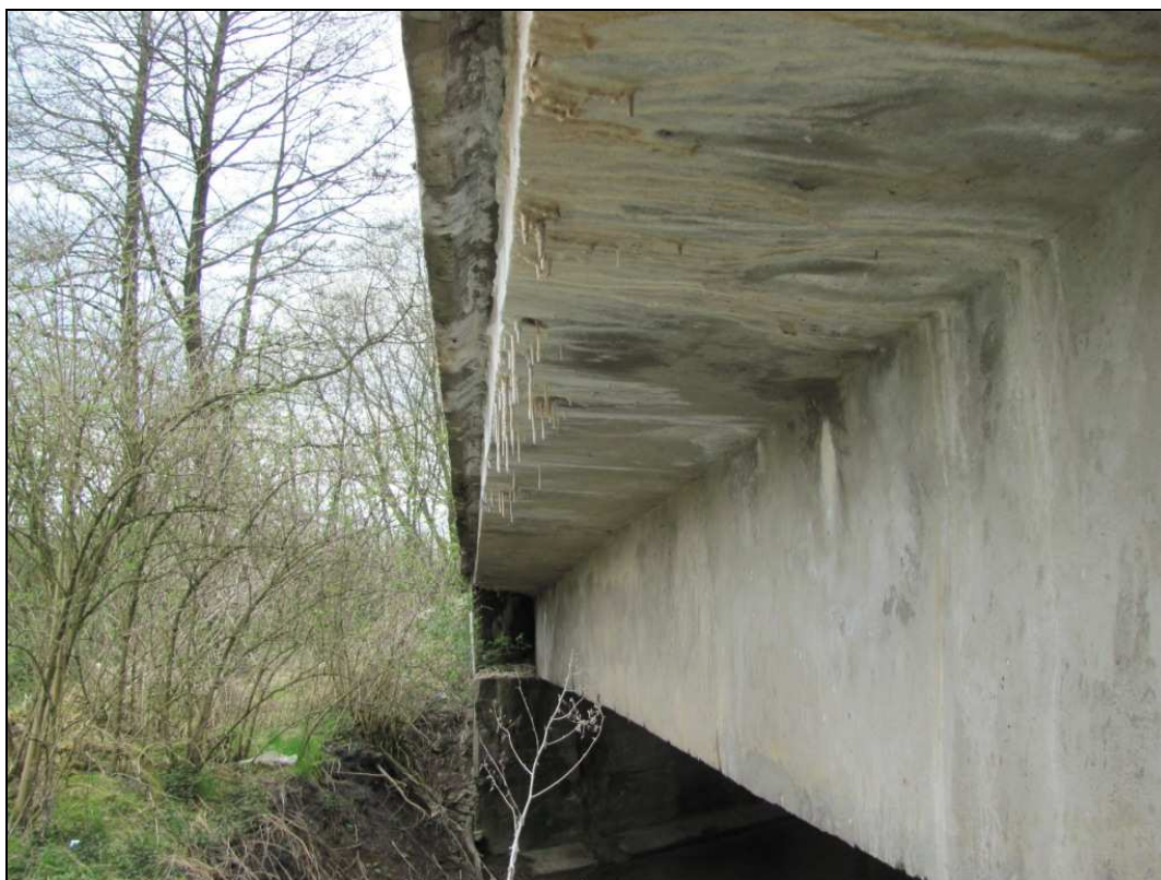
Zdj.16 Konstrukcja nośna (DW) - widoczne rozległe przecieki wody, zacieki, zawilgocenia i osady (skutek braku odpowiednich spadków na opaskach).
