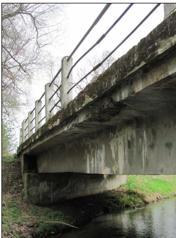
Zdj.22 Dźwigar od strony górnej wody - widoczne zacieki wody, zawilgocenia i osady.
