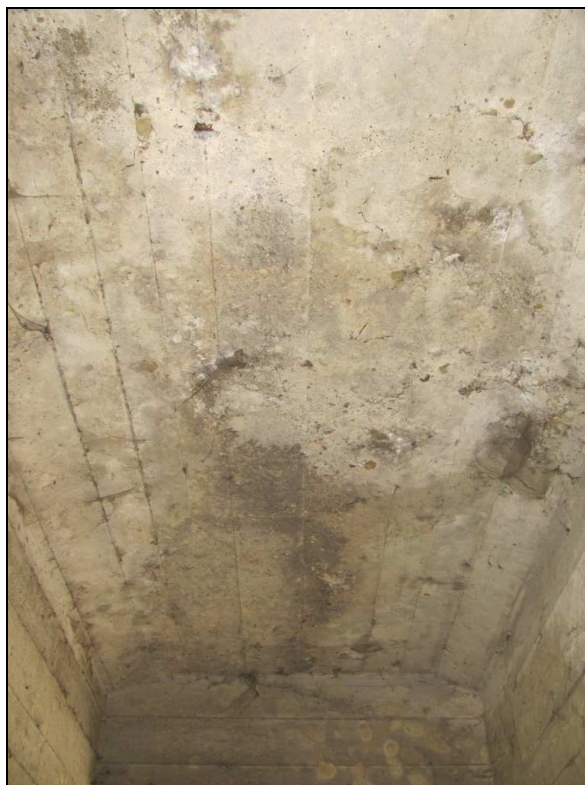
Zdj.19 Konstrukcja nośna - widoczne zawilgocenia na płycie pomostu.
