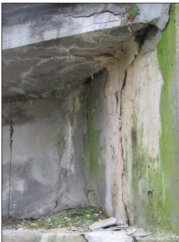
Zdj.22 Ścianka zapleczna i ława podłożyskowa przyczółka prawobrzeżnego - widoczne spękania, ubytki betonu oraz zawilgocenia i osady.
