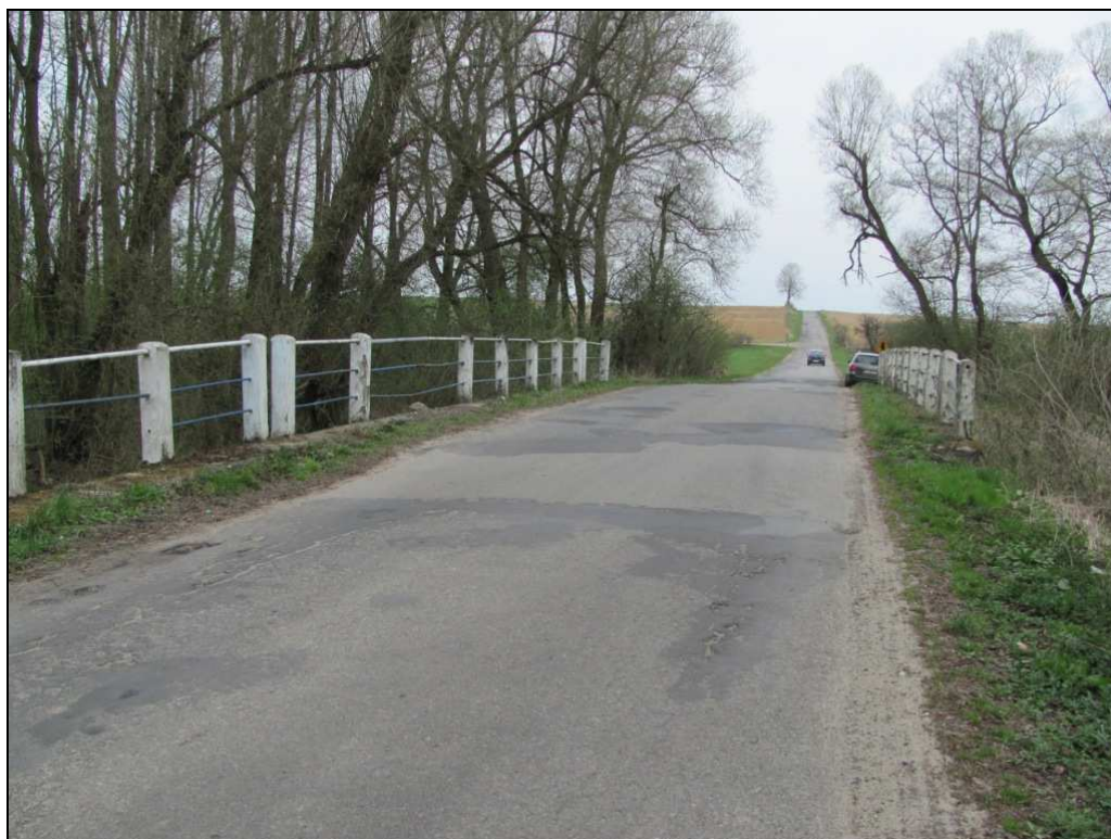
Zdj.10 Próg na wjeździe na obiekt od strony Kleszczowej .
