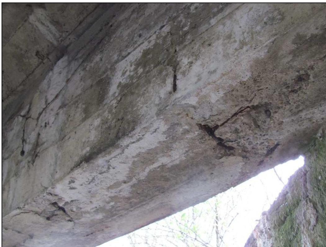
Zdj.18 Konstrukcja nośna - widoczne ubytki i korozja betonu, korozja odsłoniętego zbrojenia.
