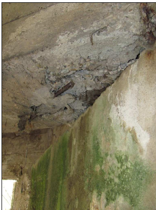
Zdj.20 Konstrukcja nośna - widoczne osłonięte skorodowane zbrojenie, ubytki betonu (niewłaściwe zagęszczenie betonu).
