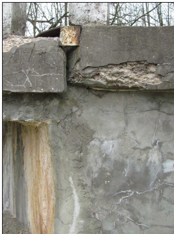
Zdj.15 Gzyms od strony dolnej wody w strefie dylatacyjnej - widoczne ubytki betonu i korozja zbrojenia oraz przemieszczenie gzymsów. Uszkodzona blacha osłonowa.
