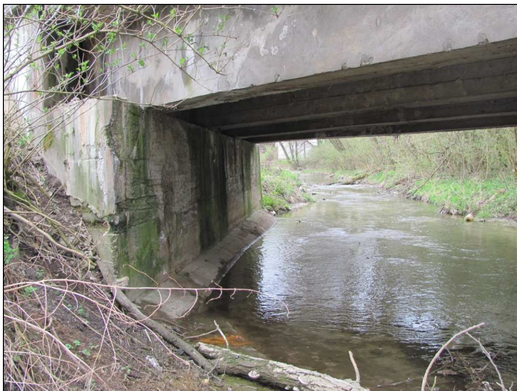
Zdj.22 Przyczółek prawobrzeżny (DW) - widoczne zawilgocenia i zielone osady (przecieki wody z szczeliny dylatacyjnej - brak szczelnego przekrycia).
