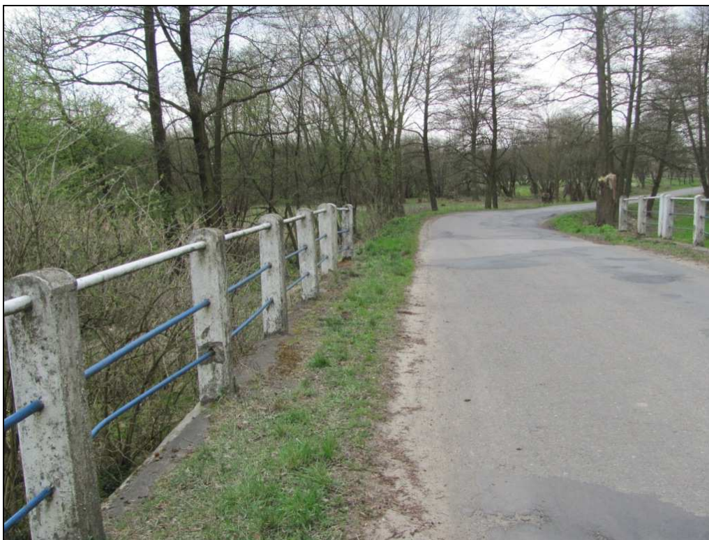
Zdj.9 Nawierzchnia jezdni wraz z opaską od strony górnej wody - widoczne zanieczyszczenia betonowej opaski, ubytki betonu słupków balustrady, korozja powierzchniowa i deformacje stalowych przeciągów.
