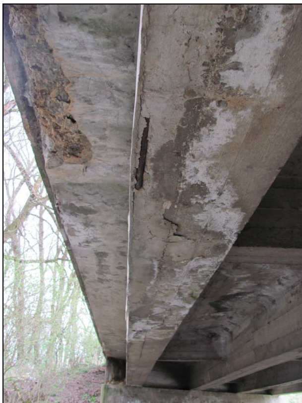
Zdj.21 Konstrukcja nośna - widoczne spękania, ubytki i korozja betonu oraz białe osady.
