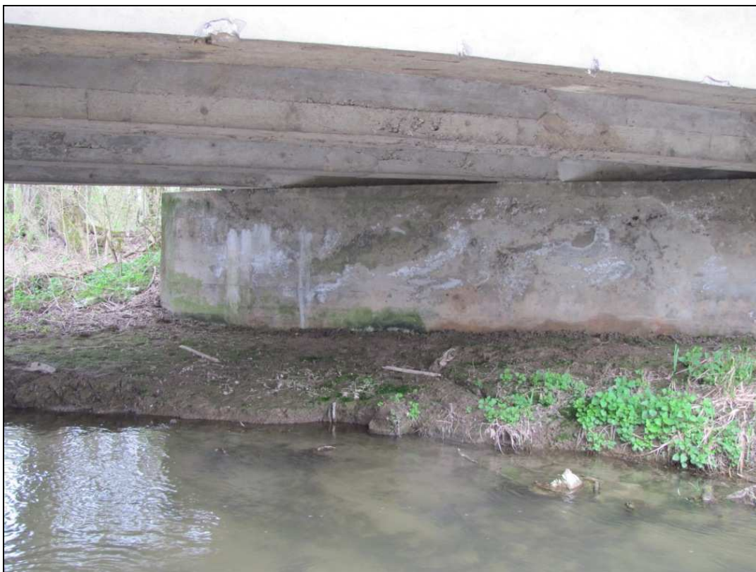
Zdj.21 Przyczółek lewobrzeżny (DW) - widoczne zawilgocenia oraz białe i zielone osady i wykwity.
