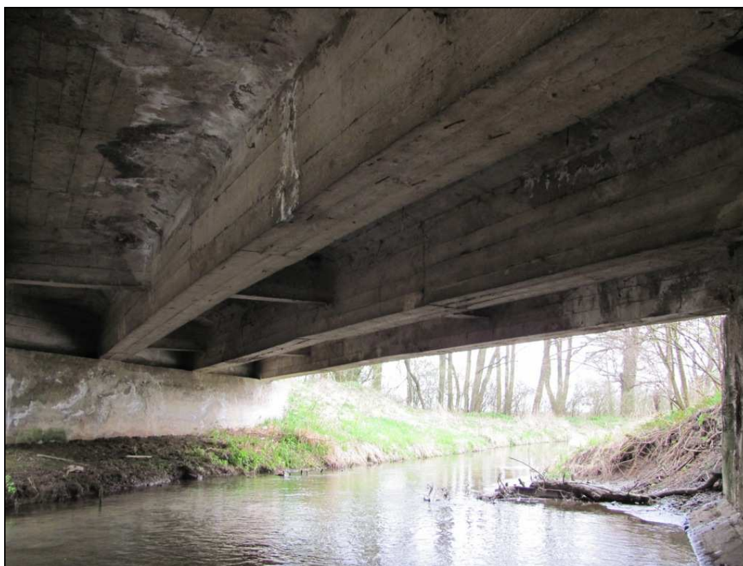
Zdj.22 Konstrukcja nośna - widoczne miejscowe zawilgocenia i osady.
