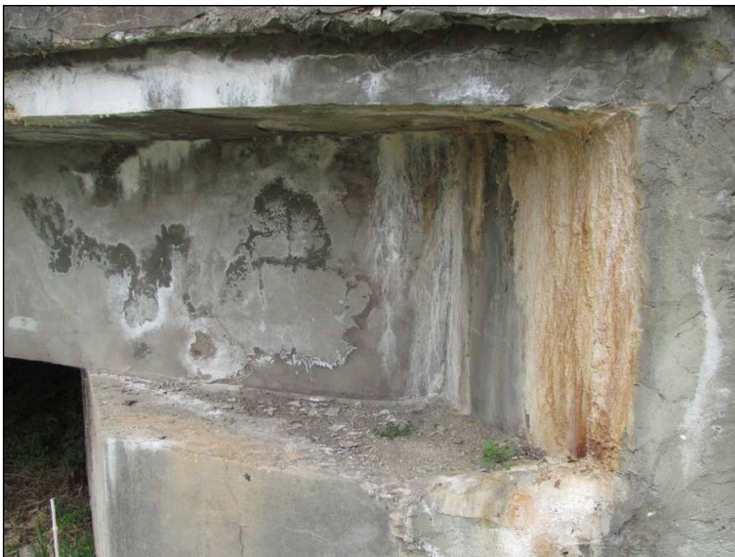
Zdj.21 Ścianka zapleczna i ława podłożyskowa przyczółka lewobrzeżnego - widoczne białe osady i wykwyty (brak szczelnego zabezpieczenia szczeliny dylatacyjnej). Zanieczyszczenia niszy podłożyskowej.
