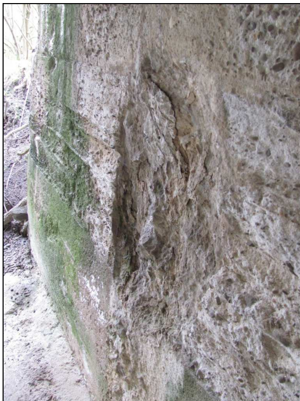
Zdj.21 Przyczółek prawobrzeżny - widoczne rozległe ubytki i korozja betonu.
