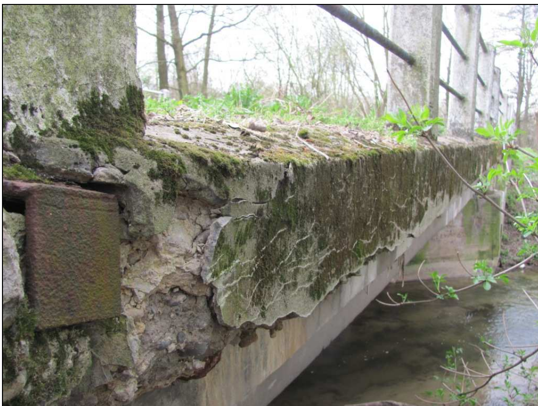
Zdj.12 Gzyms od strony górnej wody - widoczna rozległa korozja i ubytki betonu, wegetacja mchów.
