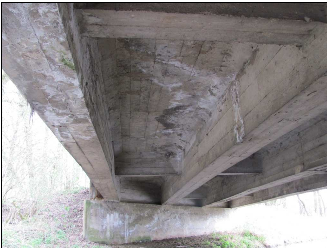
Zdj.21 Konstrukcja nośna - widoczne zawilgocenia oraz białe osady na spodzie skrajnego dźwigara oraz na płycie pomostu.
