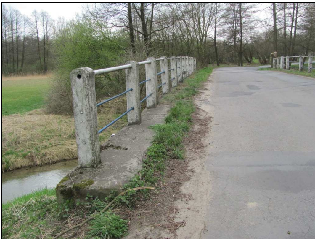
Zdj.6 Nawierzchnia jezdni wraz z opaską od strony dolnej wody - widoczne deformacje, spękania oraz zanieczyszczenia w strefie przykrawężnikowej.
