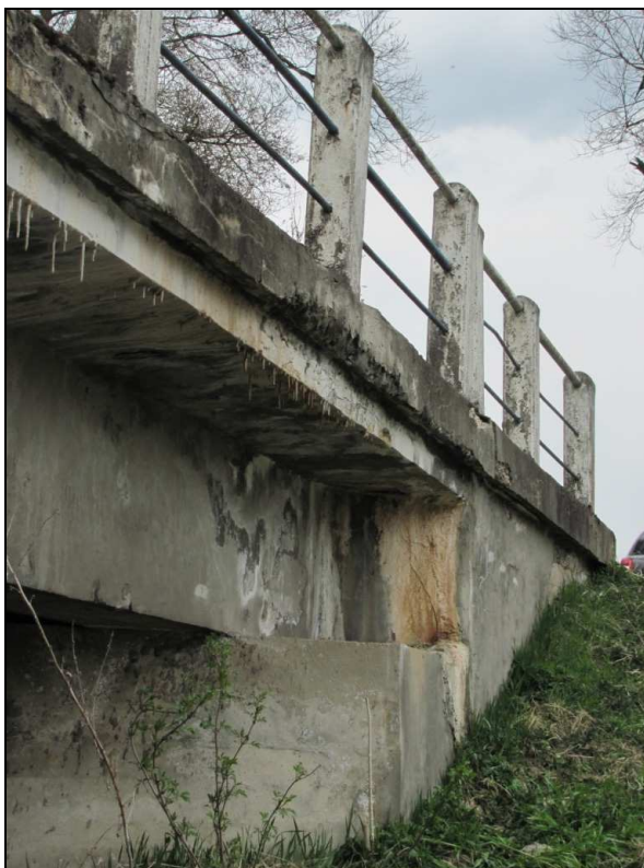
Zdj.17 Konstrukcja nośna (DW) - widoczne zawilgocenia i osady na wsporniku i bocznej powierzchni dźwigara (nieprawidłowe spadki na betonowej opasce, brak szczelnego przekrycia szczeliny dylatacyjnej).
